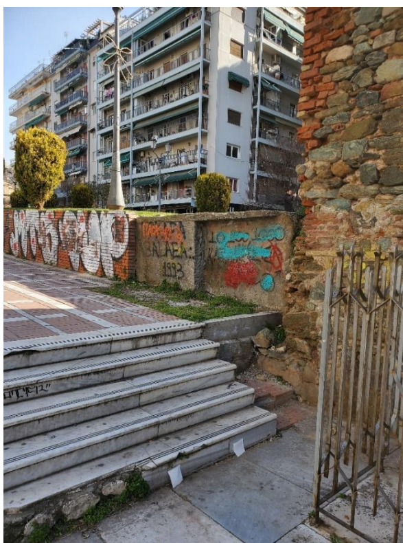
Εικόνα: Πολιτικό σπρέι στην περιοχή της Καμάρας-Θεσσαλονίκη
